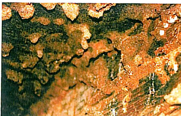
Holzkonstruktion mit umfassendem Insektenbefall
