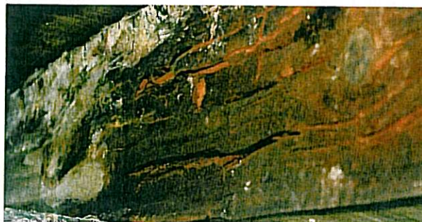
Holzkonstruktion mit umfassendem Insektenbefall
